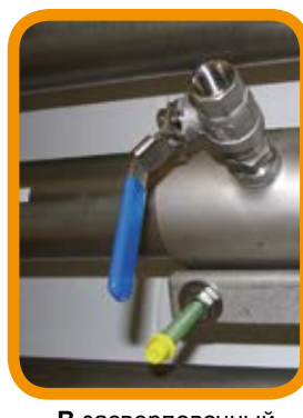
В засверловочный хомут
