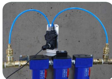
Стандартное применение датчика дифференциального давления: присоединение двумя полиэтиленовыми трубками к трубопроводу до и после фильтра.
